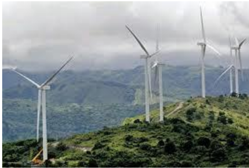
Gambar 37. Pembangkit Listrik Tenaga Bayu Sidrap (Sumber: Sulselsatu)
