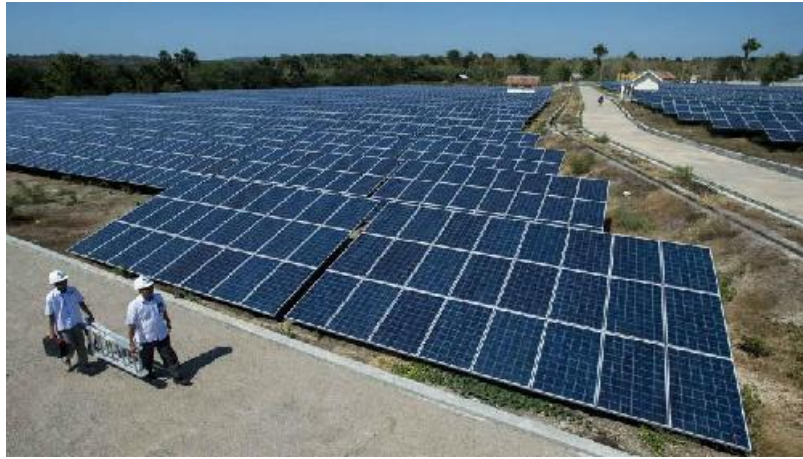
Gambar 73. Pembangkit Listrik Tenaga Surya Kupang (Sumber: Detik)
