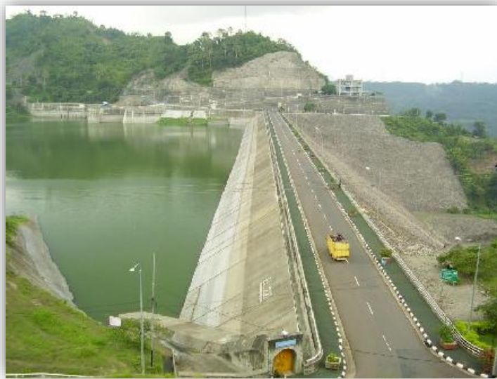
Gambar 7. Pembangkit Listrik Tenaga Air Cirata (Sumber: Tri Indonesia)
